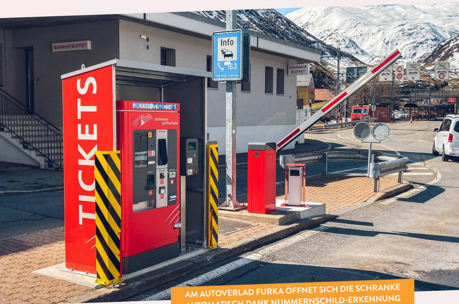
AM AUTOVERLAD FURKA ÖFFNET SICH DIE SCHRANKE AUTOMATISCH DANK NUMMERSCHILD-ERKENNUNG
